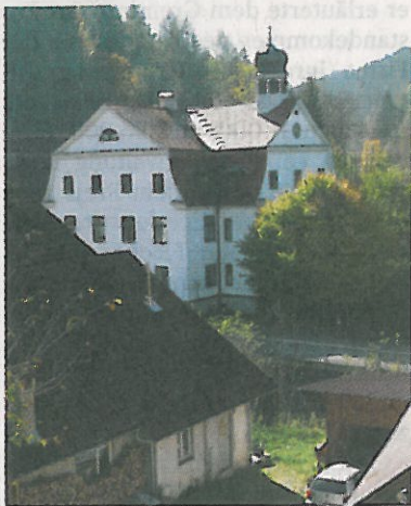
Markant im Ortsbild von Kreuzthal: Das Haus Tanne ist ein ehemaliges Glasmacherhaus
